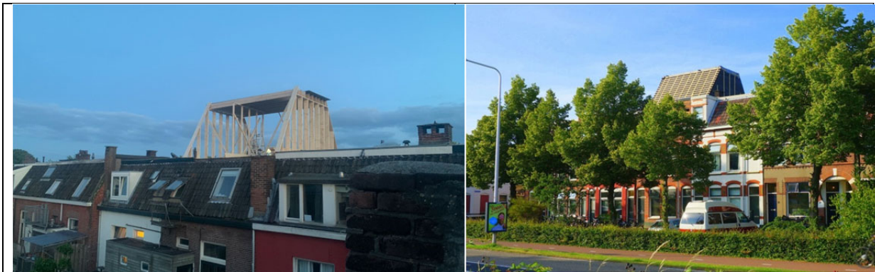
Bouw van het dakappartement op Deventerstraatweg 11 juli 2022
