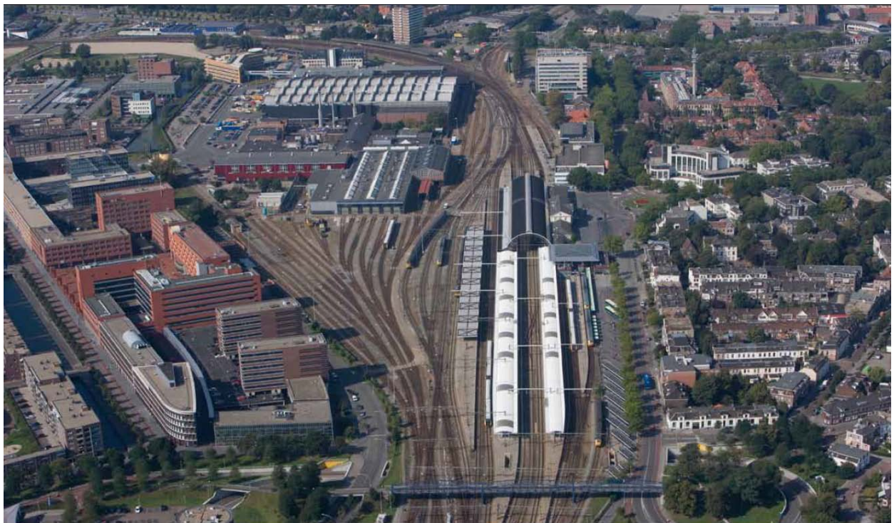
Spoorzone voordat de verbouwing van het station begon.
