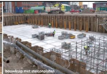
bouwkuip met stelconplaten
